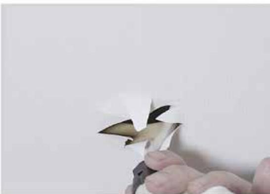
5. Découper le centre en étoile pour extraire la partie électrique et réaliser le branchement.
