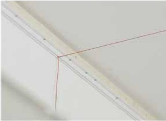
1. Insérer une ficelle dans les profils pour le niveau.
